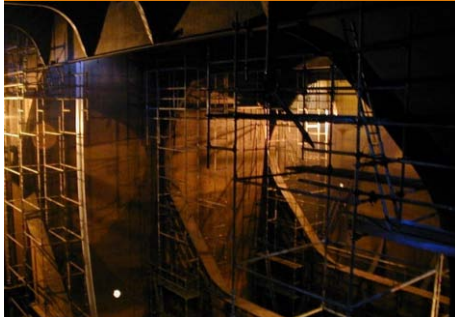
Gerüstaufbau für die Inspektion eines Laderaumes.
