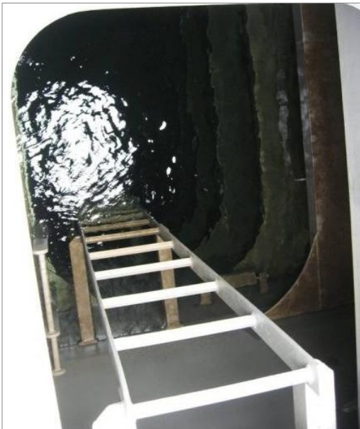
Teilgefluteter Arbeitsbereich in Ballastwassertank ©Det Norske Veritas
